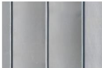
Zinc naturel à joints debout (débord de toiture, zinc naturel pour les gouttières et DEP)
