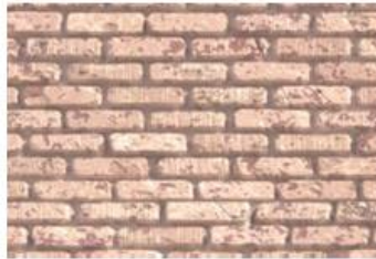
Briques pleines (façades rue et jardin)
