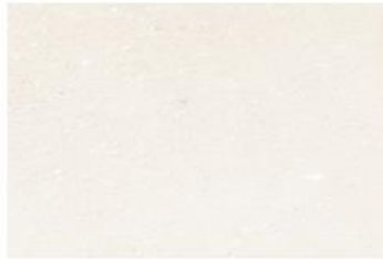
Enduit à la chaux de teinte claire (pignons)
